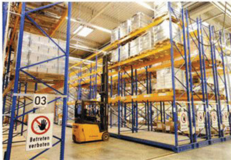
Herzstück des Lagers ist eine automatische Verschieberegalanlage mit vier zu öffnenden Gängen, die durch das Jungheinrich-WMS gesteuert wird
